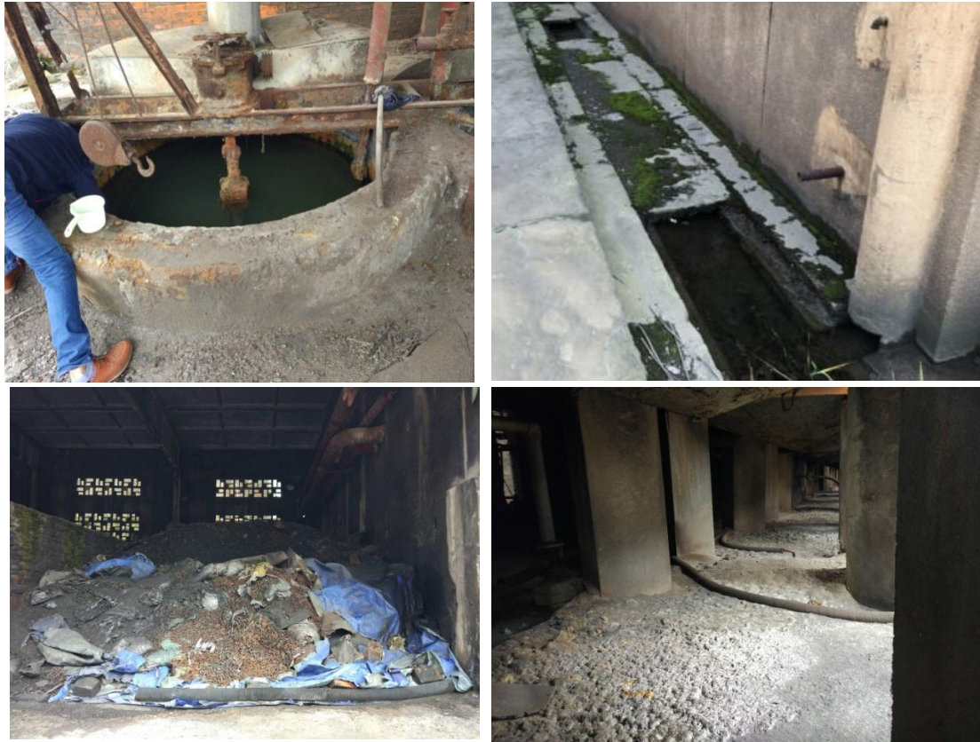
图 2-3 地块存留设备、废液、废渣现状
